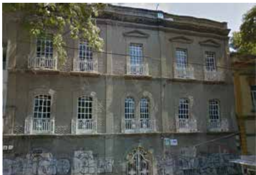
Rehabilitación de inmueble en riesgo estructural en Mérida, No. 90, Col. Roma.
